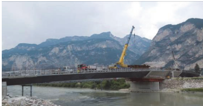
Nelle foto, il vecchio ed il nuovo ponte al termine della costruzione
