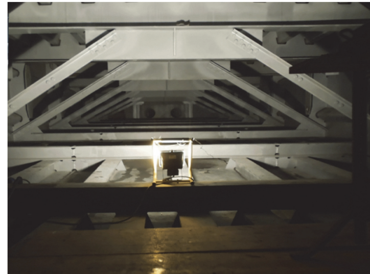
Nelle foto, in evidenza, la struttura interna del ponte in acciaio.
