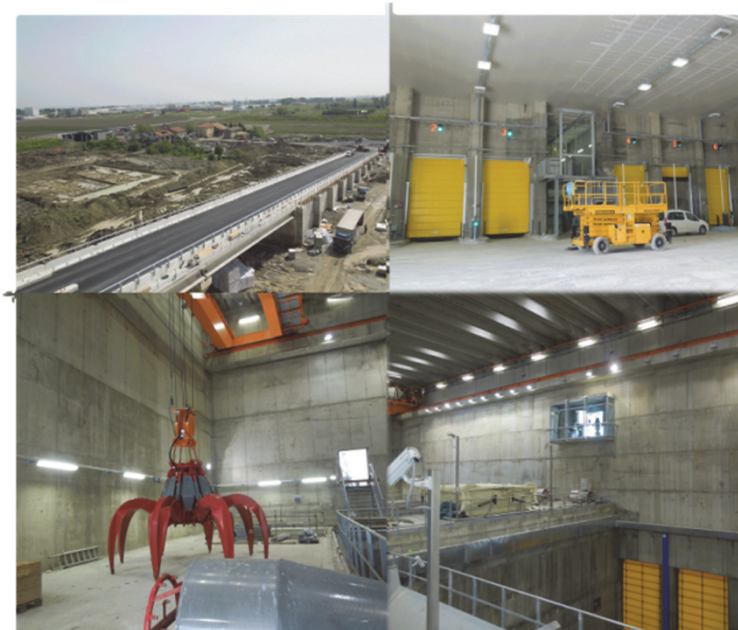
Nelle foto sopra, Il sistema di ricezione dei rifiuti che comprende parte del sistema di movimentazione, piazzale di scarico, avanfossa e fossa rifiuti.
